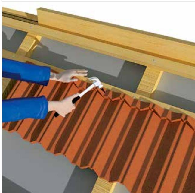
Черепица укладывается посредством подъема обоих кровельных листов в ряду и запуска нижний ряд под уже установленную черепицу. Начиная установку от уже уложенного ряда, укладывайте два ряда одновременно от края до края фронтону. Кровельщик, укладывающий черепицу, должен быть на два ряда впереди кровельщика, осуществляющего крепление черепицы на гвозди.
